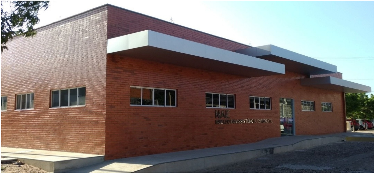
Prédio da PRAE
